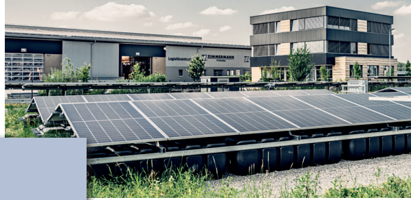
Neubau Büro in Oberessendorf
