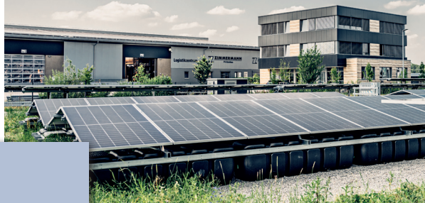
Neubau Büro in Oberessendorf
